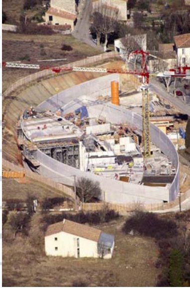
Le chantier du musée (mars 1999) © Jean Gagnepain
